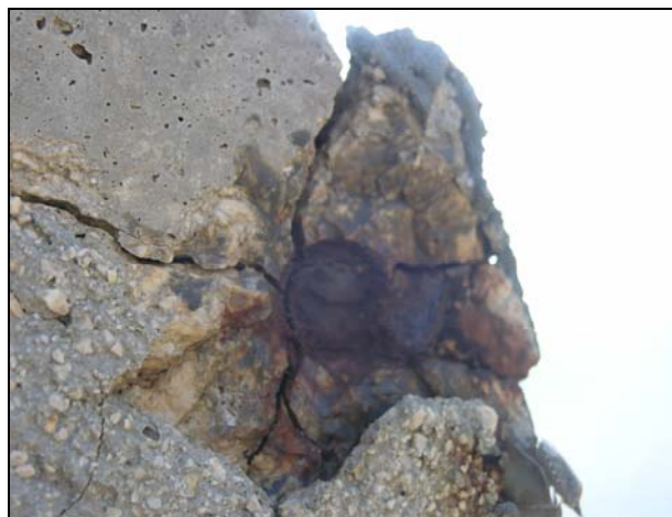
Slika 2.3.1.2.3::1 Povećanje volumena prilikom korozije čelika u armiranom betonu
