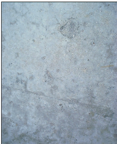
Slika 2.3.1.2.2::2 Pojava mikropukotina
