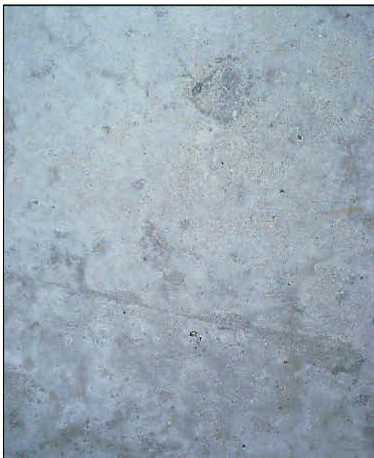
Slika 4.3.1.2.2::2 Pojava mikropukotina
