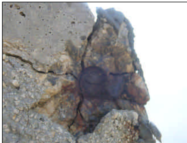
Slika 4.3.1.2.3::1 Povećanje volumena prilikom korozije celika u armiranom betonu
