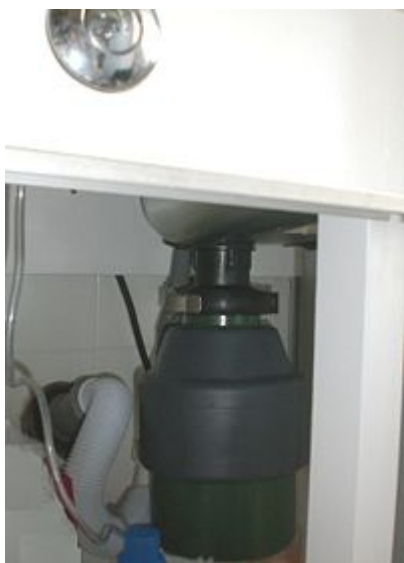
Sl. 12 Usitnjivač otpada montiran ispod kuhinjskog sudopera
