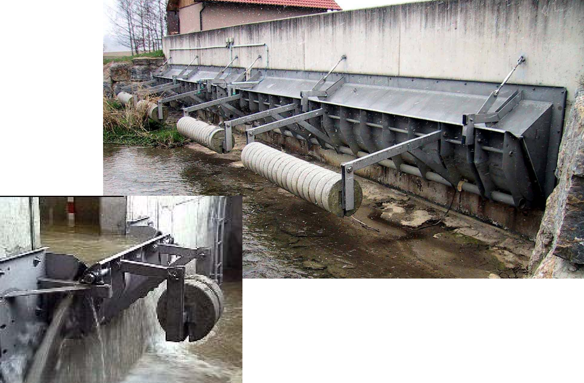
Mehanički upravljano rasterečenje s protuutezima
