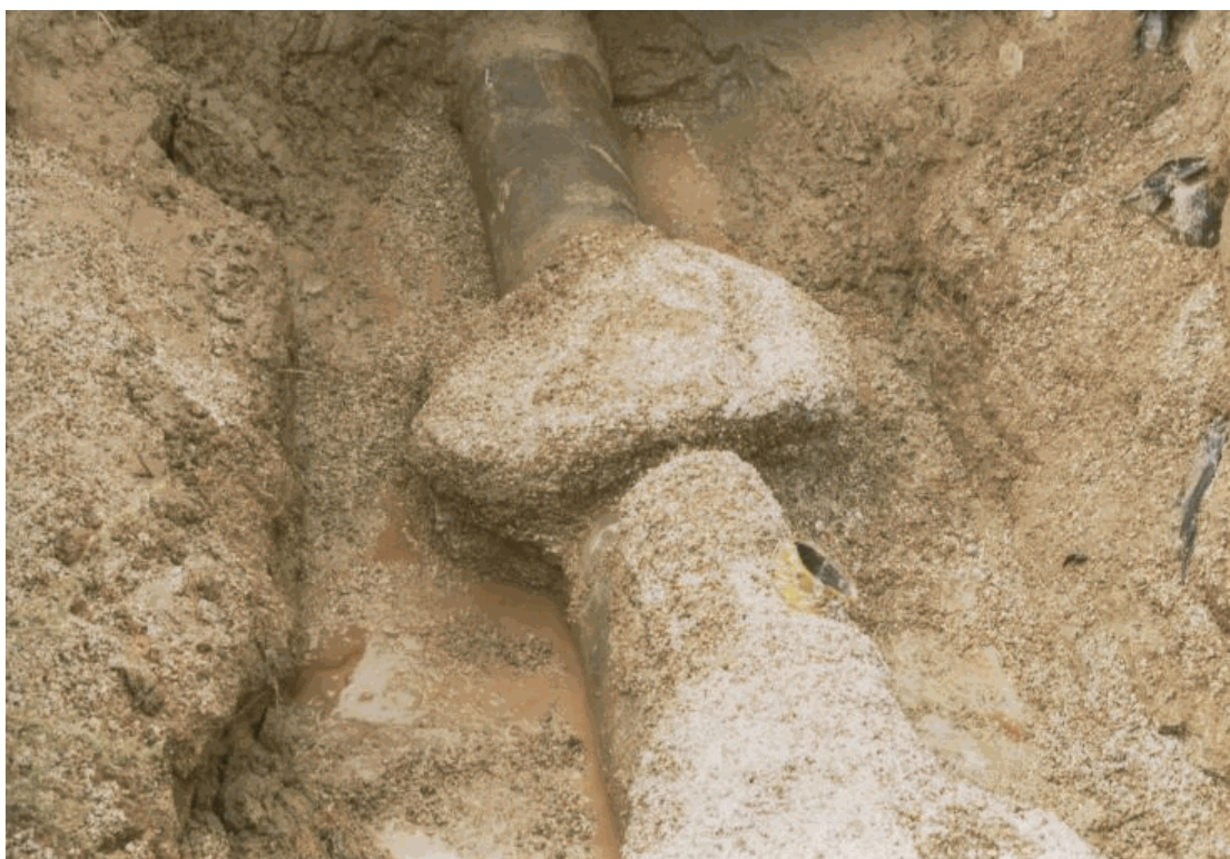
Sanirana cijev – Vidljivo odebljanje od gela na mjestu pukotine
