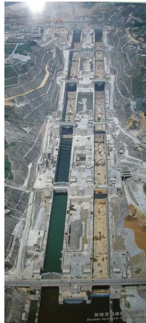
Slika 4.9.:5 Pevodnice u nizu idizalo za čamce na akumulaciji Three Gorges, Jang Tse Qjang, Kina 2002. visina dizanja 110[m]
