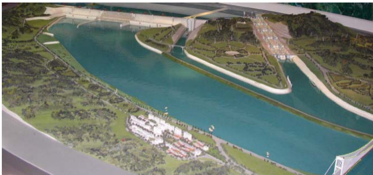
Slika 4.9.:5 Pevodnice u nizu idizalo za čamce na akumulaciji Three Gorges, Jang Tse Qjang, Kina 2002. visina dizanja 110[m]
