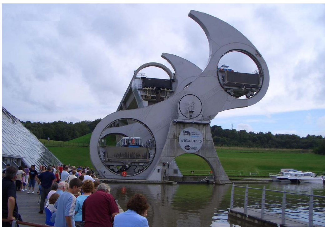
Slika 4.9::2 Brodsko dizalo "Falkirk Wheel" na kanalu Forth & Clyde u Škotskoj. Ima visinu prevođenja 24 m, trajanje prevođenja 15 min i mjerodavni brod dužine 25m, deplasmana 300 t. Služi u turističke svrhe. [Internet]
