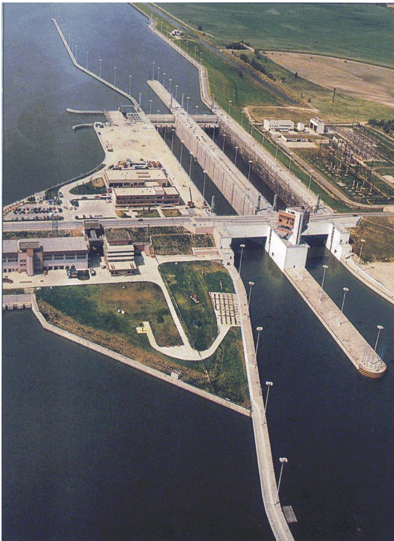
Slika 4.9::4 Dvojna prevodnica na na višenamjenskoj akumulaciji Gabčíkovo, Dunav u Slovačkoj [Prospekt RMD 20xy] n
