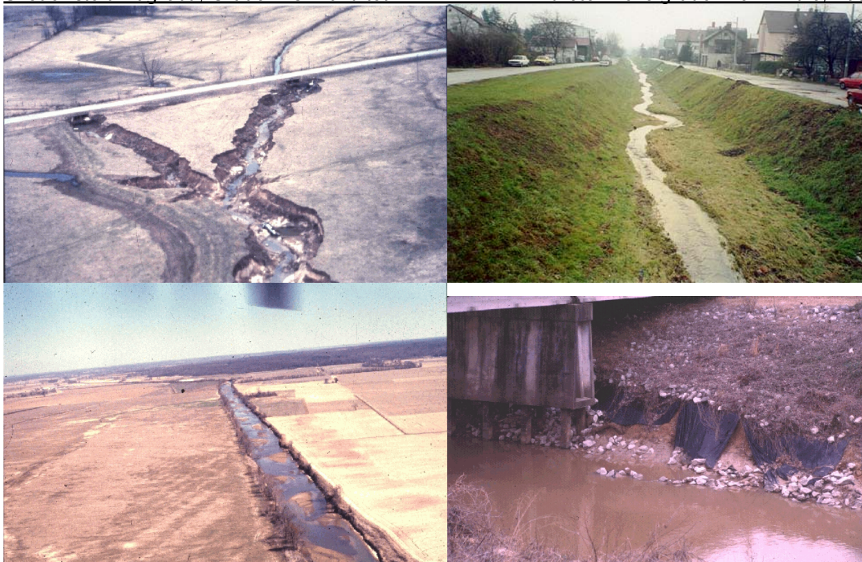
Slika 2.2.:1 Primjeri neadekvatnog uređenja vodotoka
