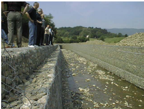
Slika 2.2.3::4 Vertikalne gravitacijska obaloutvrda od gabionskih košara
