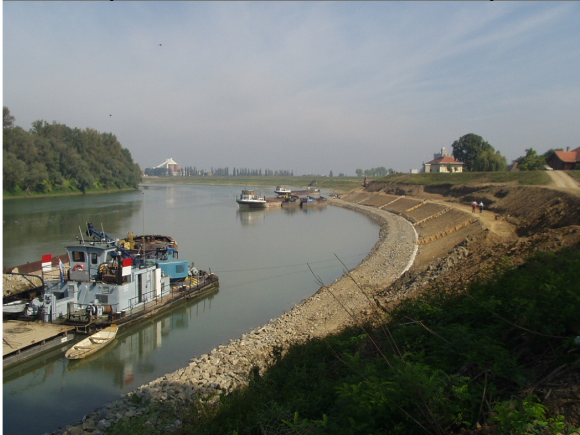
Slika 2.2.3::6 Kosa obaloutvrda s oblogom od lomljenog kamena
