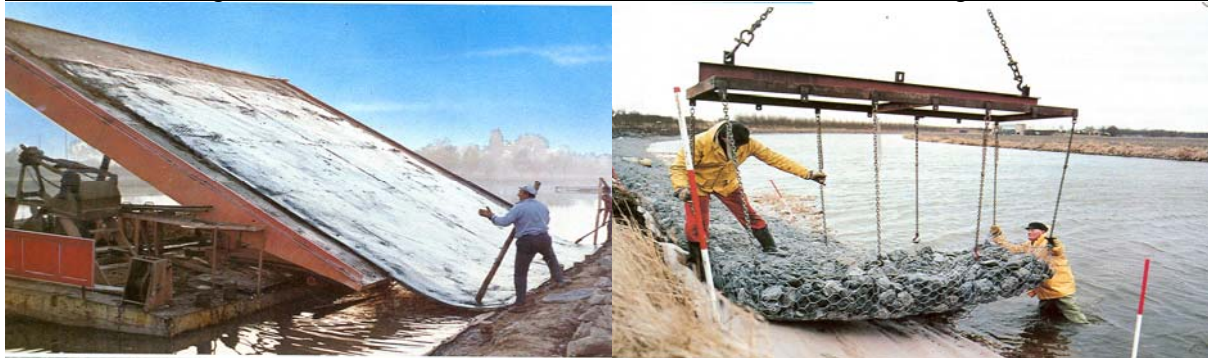
Slika 2.2.3::7 Kosa obaloutvrda s oblogom od gabionskih madraca
