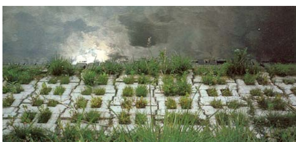
Slika 2.2.3::8 Kose obaloutvrde s oblogom od betonskih blokova
