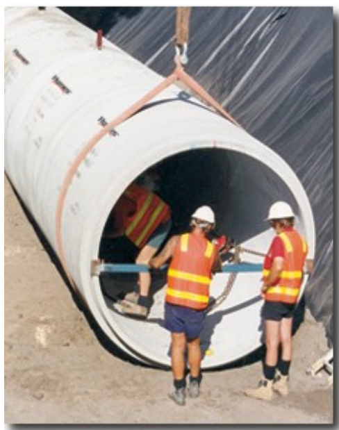
Slika 3.1-1 Armiranobetonska cijev
