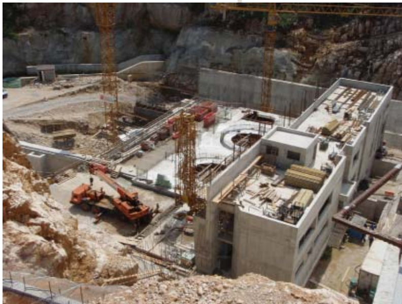
He Lešće – izgradnja strojarnice 2008.
