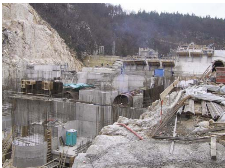
HE Lešće – izgradnja strojarnice i brane 2007
