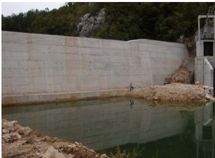
HE Lešće – dovršeni uzvodni zagat
