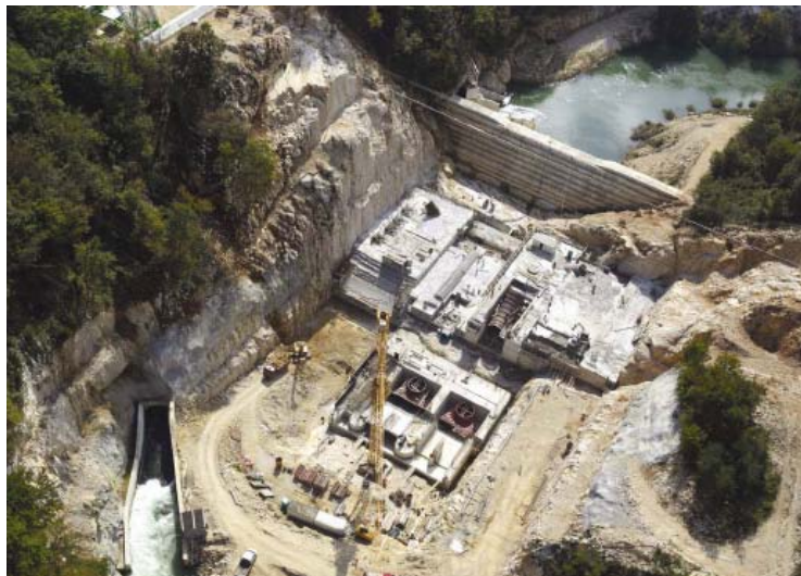
HE Lešće – izgradnja brane u građevnoj jami - 2007
