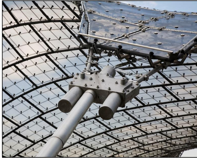
Slika 9: Ležajni čvor [20]
