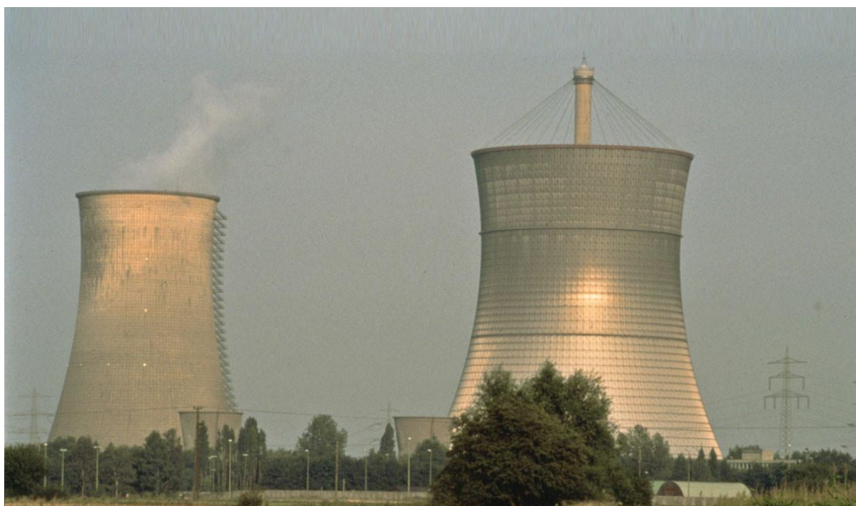
4. Rashladni toranj atomske centrale od mreže kabela, Schmehausen
