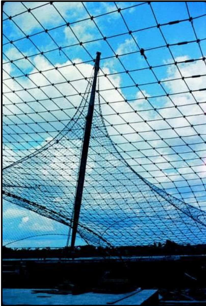
Slika 4: Mreža užadi Njemačkog paviljona na Svjetskoj izložbi u Montrealu, 1967.
