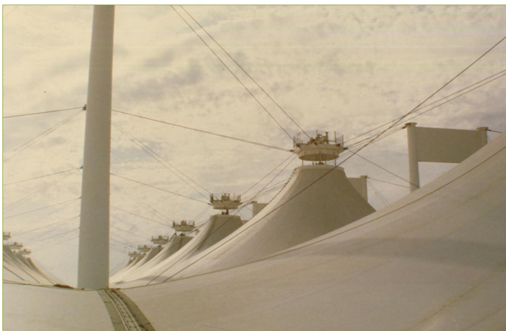
Slika 4: Detalji platna krovinskog sustava aerodroma Jeddah, Hajj terminal [8]
