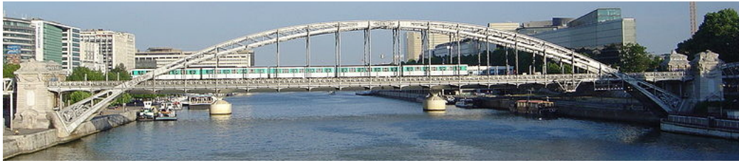
Viaduc d'Austerlitz, Pariz, 1904.
